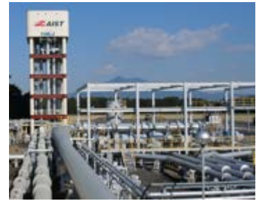
大流量校正設備
